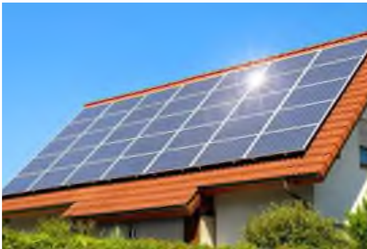
Instalarea pe acoperiș a panourilor solare
